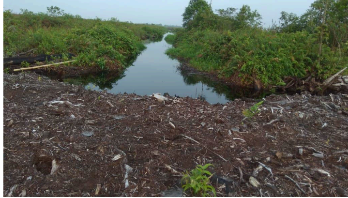
Gambar 10 Kondisi ketinggian muka air pada salah satu titik yang akan dipasang indikator muka air gambut
