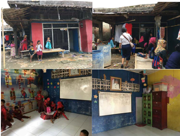
Gambar 1 Kondisi Bangunan Sekolah Cahaya Al- Fuqron Lama
