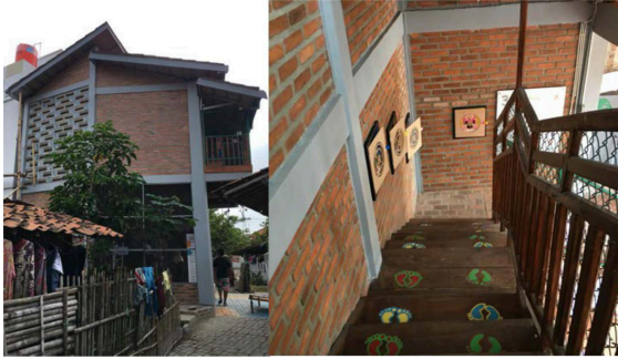
Gambar 4 Kondisi gedung PAUD yang baru dibangun sumber: Dokumen Pribadi, 2016
