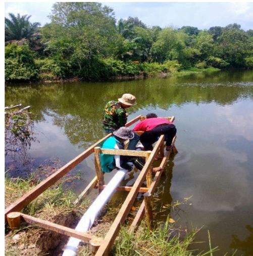
Gambar 4 Pemasangan Pipa Masuk ke Pompa di danau Kiyam
