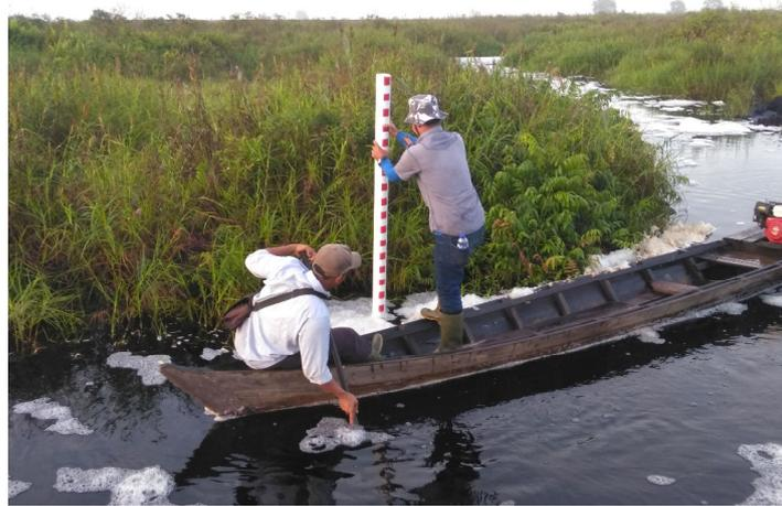
Gambar 11 Pemasangan alat pengamatan tinggi muka air gambut
