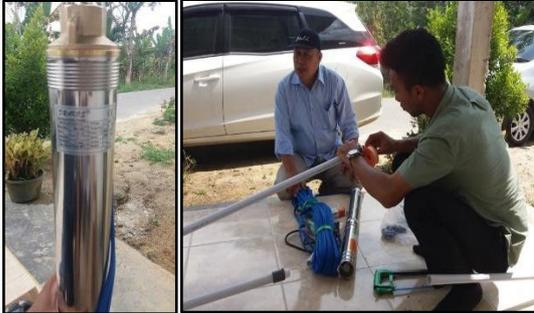
Gambar 7 Bentuk Fisik Pompa Celup dan Proses Perakitannya
