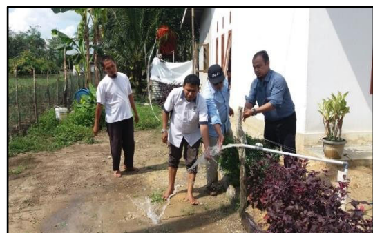
Gambar 9 Pengujian Operasi Pompa Celup.
