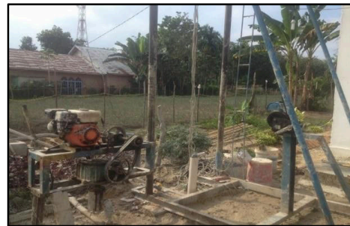
Gambar 6 Pembangunan Sumur Bor
